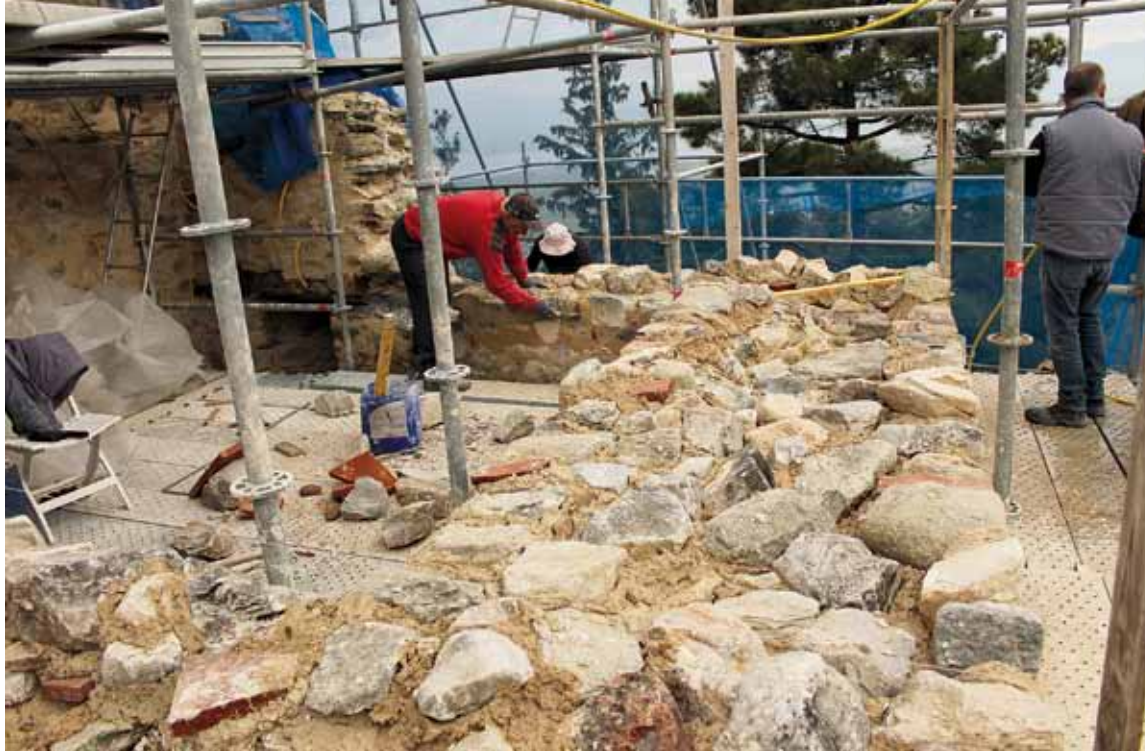
Εικ. 58. Ανάκτηση τοιχοποιίας του δυτικού πύργου της ακρόπολης.
