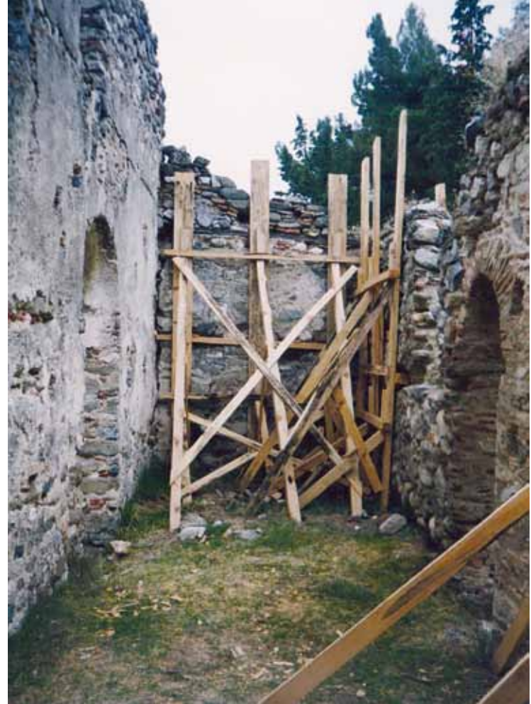
Εικ. 50. Αναστηλωτικές εργασίες στη βασιλική των Σερβίων τρεις μήνες μετά τον σεισμό του 1995.
