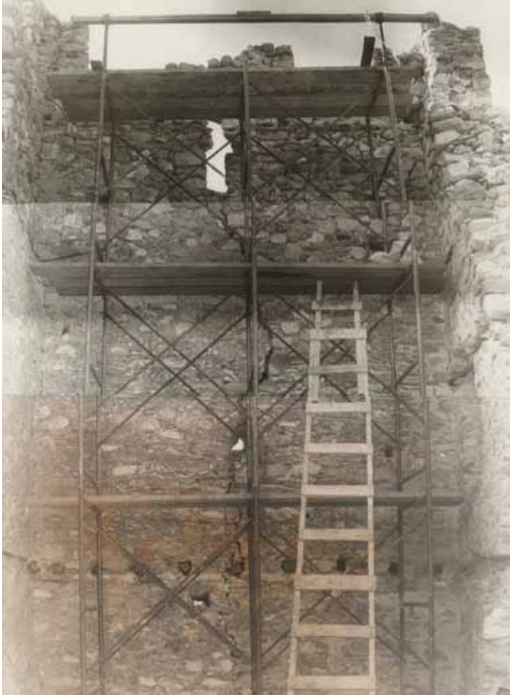
Εικ. 49. Αναστηλωτικές εργασίες στον δυτικό πύργο της ακρόπολης κατά το έτος 1987.
