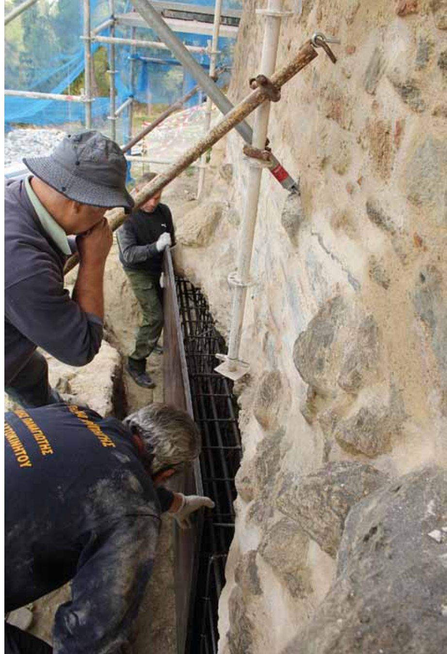
Εικ. 56 και 57. Εργασίες κατασκευής υποθεμελίωσης του δυτικού πύργου της ακρόπολης (κατασκευή αφανούς δοκού από σπλισμένο σκυρόδεμα). Fig. 56 and 57 Sub-foundation construction on the western tower of the citadel (construction of an absent reinforced concrete beam).
