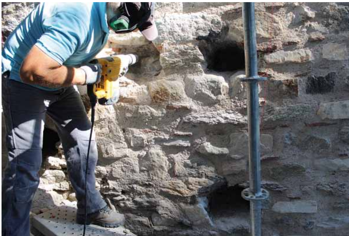
Εικ. 59. Διατμητικές φωλιές στο μεσοπύργιο (νότια πλευρά) για τη σύνδεση του με τη νέα ανάκτηση στον δυτικό πύργο της ακρόπολης.
