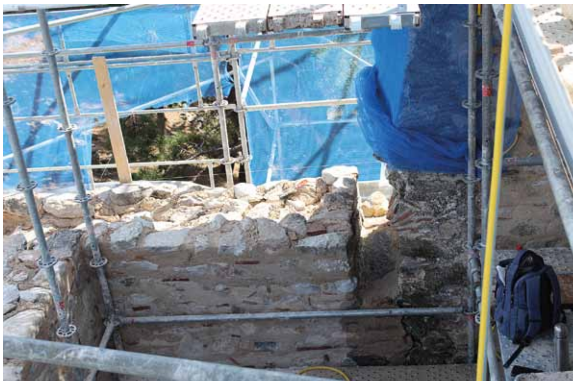
Εικ. 55. Ανάκτηση της τοξοθυρίδας στη νότια όψη του δυτικού πύργου της ακρόπολης. Fig. 55. Recovery of the arched opening on the southern face of the western tower of the citadel.
