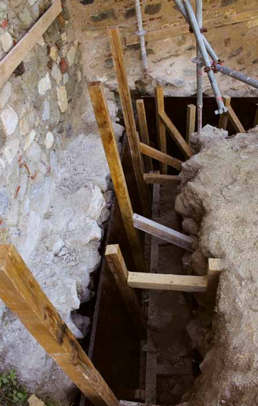
Εικ. 56 και 57. Εργασίες κατασκευής υποθεμελίωσης του δυτικού πύργου της ακρόπολης (κατασκευή αφανούς δοκού από σπλισμένο σκυρόδεμα). Fig. 56 and 57 Sub-foundation construction on the western tower of the citadel (construction of an absent reinforced concrete beam).
