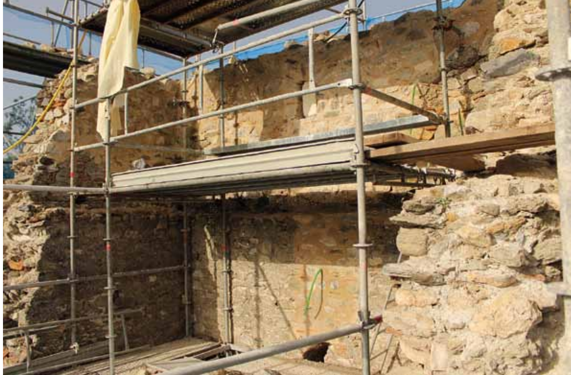
Εικ. 54. Επισκευή διαμπερούς ρηγματώσης του δυτικού πύργου της ακρόπολης. Fig. 54. Repair of through cracking of the western tower of the citadel.
